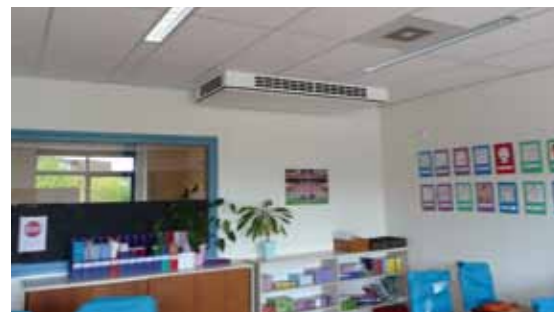
Plaatsing verse lucht aan- en afvoer in de klassen
